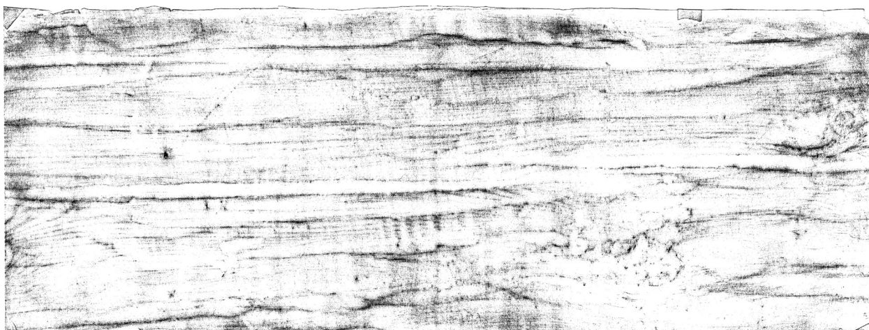
Spår efter skave på väggtimmer i Ygshärbret.
