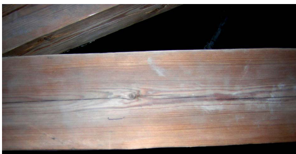
Urslag runt kvist (gipsavgjutning).
