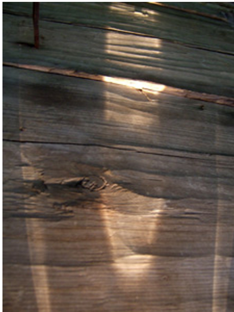
Väggtimmer i en byggnad som antas vara ett tidigare vapenhus till Rödö kyrka.
