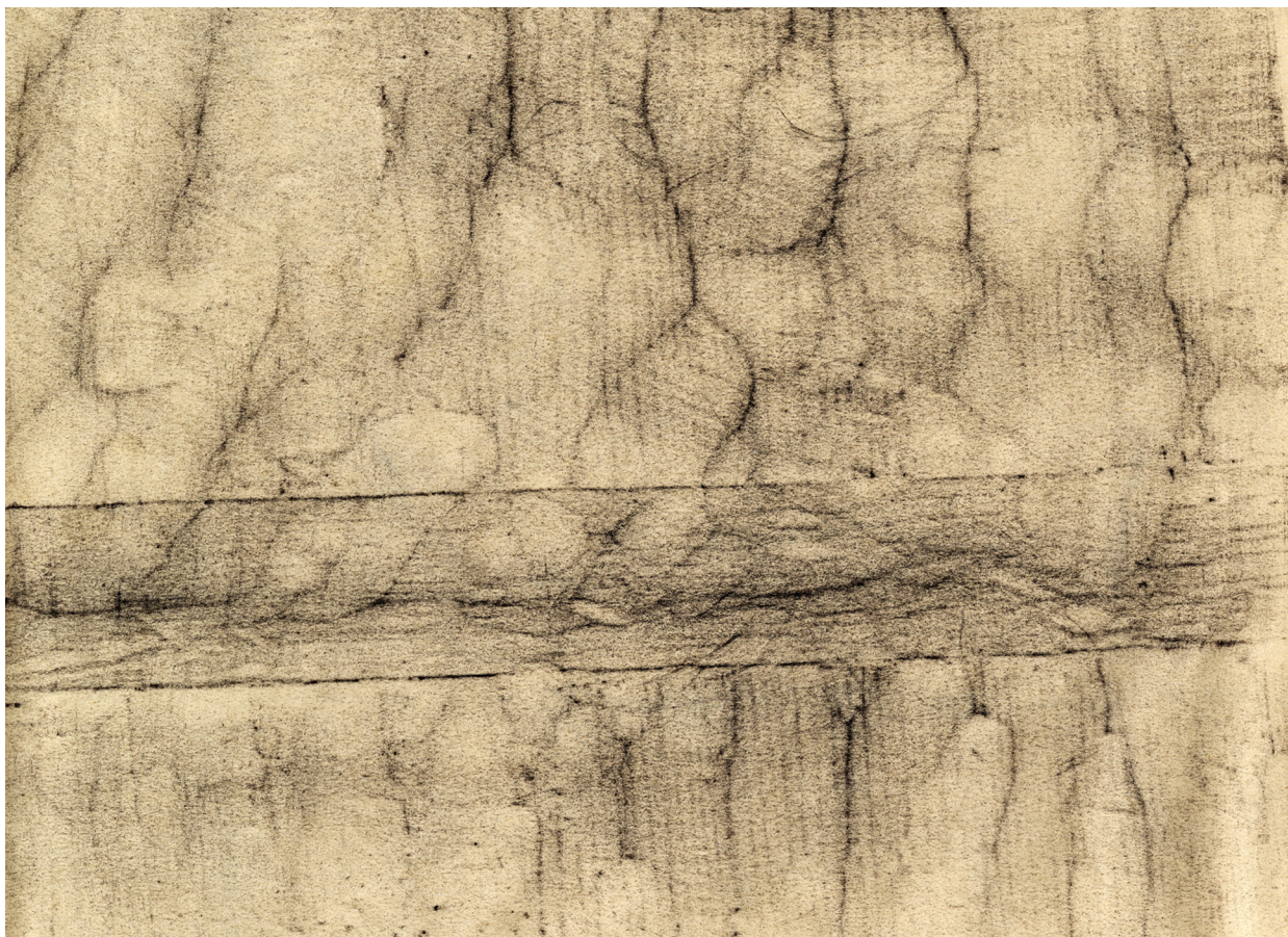
Spår efter skave in på nara i en dörr på Älvalens kyrkhärbre.
