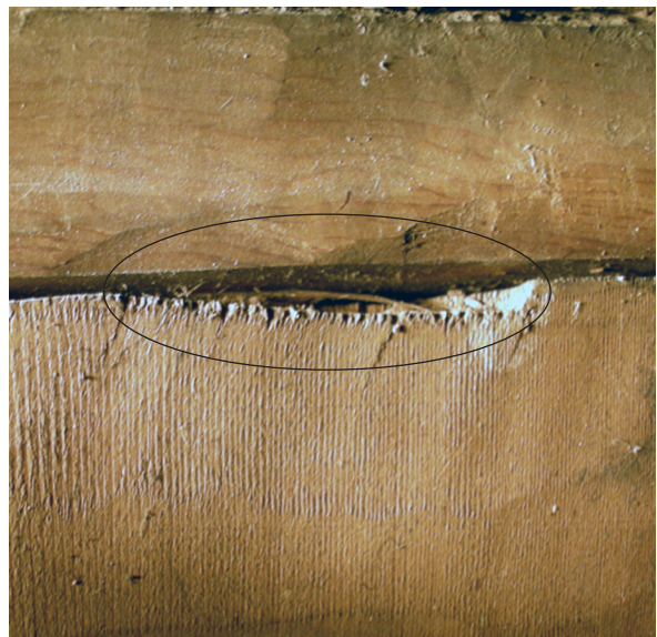
Spår efter yxhugg från gradspårets upphuggning.
