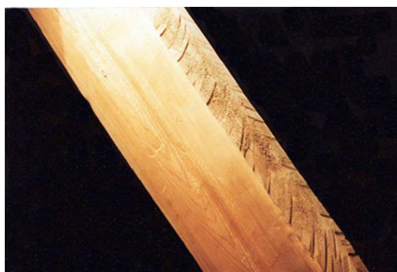
Högs kyrka Högben med spår efter skave och yxa. Foto B. Björk 1999.
