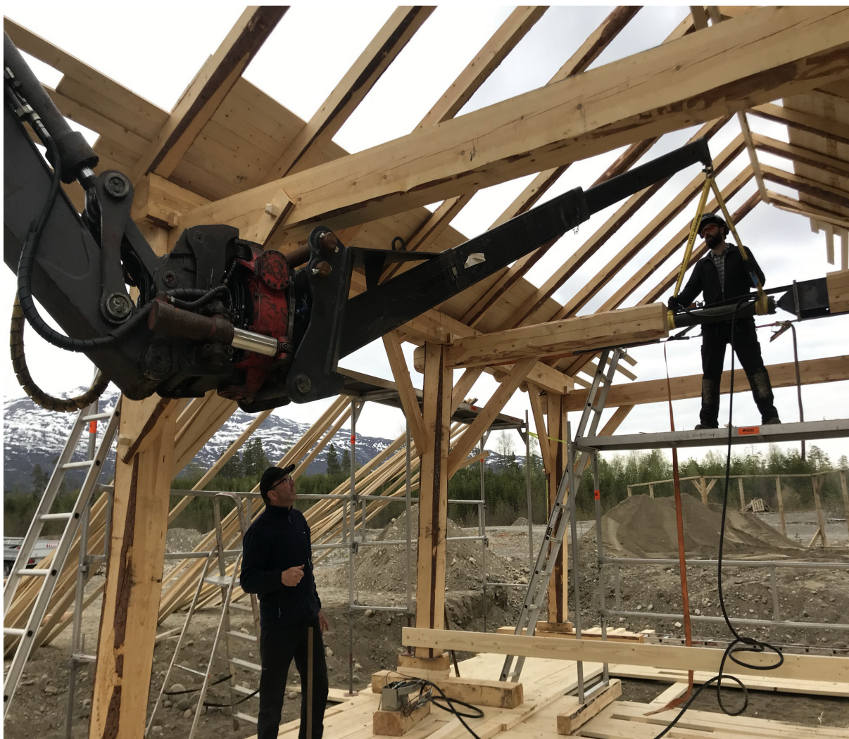
Fig. 18. Her vert strekk-målar montert inn i beten.
