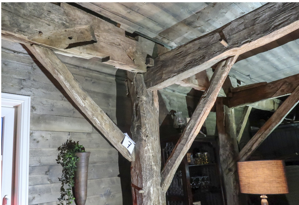
Fig. 13. Frå løa til Håvard H. Kleiveland på Vedo. Oppe i venstre hjørna av bildet syner eit bandahakk etter eit flatare liggjande snedband. Stavleia er oppattbrukt, slike flatare hakk etter snedband er typiske å finna.
