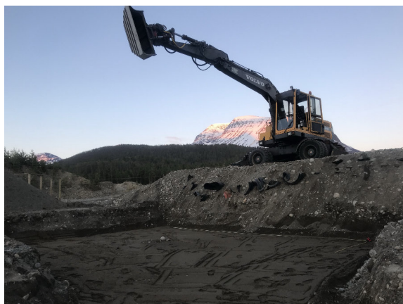
Fig. 28. Venstre: Målselv den 28.05.2019 klokka 01:15: Nattskift der tomte er ferdig planert og klar til komprimering. Høgre: Tre-fundamentet er starta på. Det gjekk med rett i overkant av 2,5 kilometer med konstruksjonsvirke.
