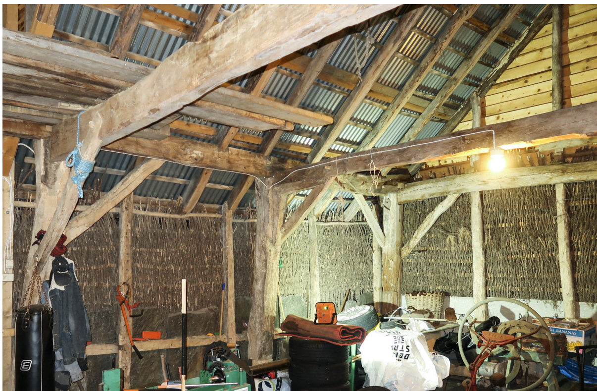
Fig. 10. Løa til Rolf M. Kleiveland på Kleiveland. Legg merke til den underlege, men enno – meir eller mindre – fungerande skøyten på stavleia nesten heilt ute mot gavlen. Dei gamle tømrrarane kvidde seg ikkje med å vera praktiske viss det var nødvendig.
