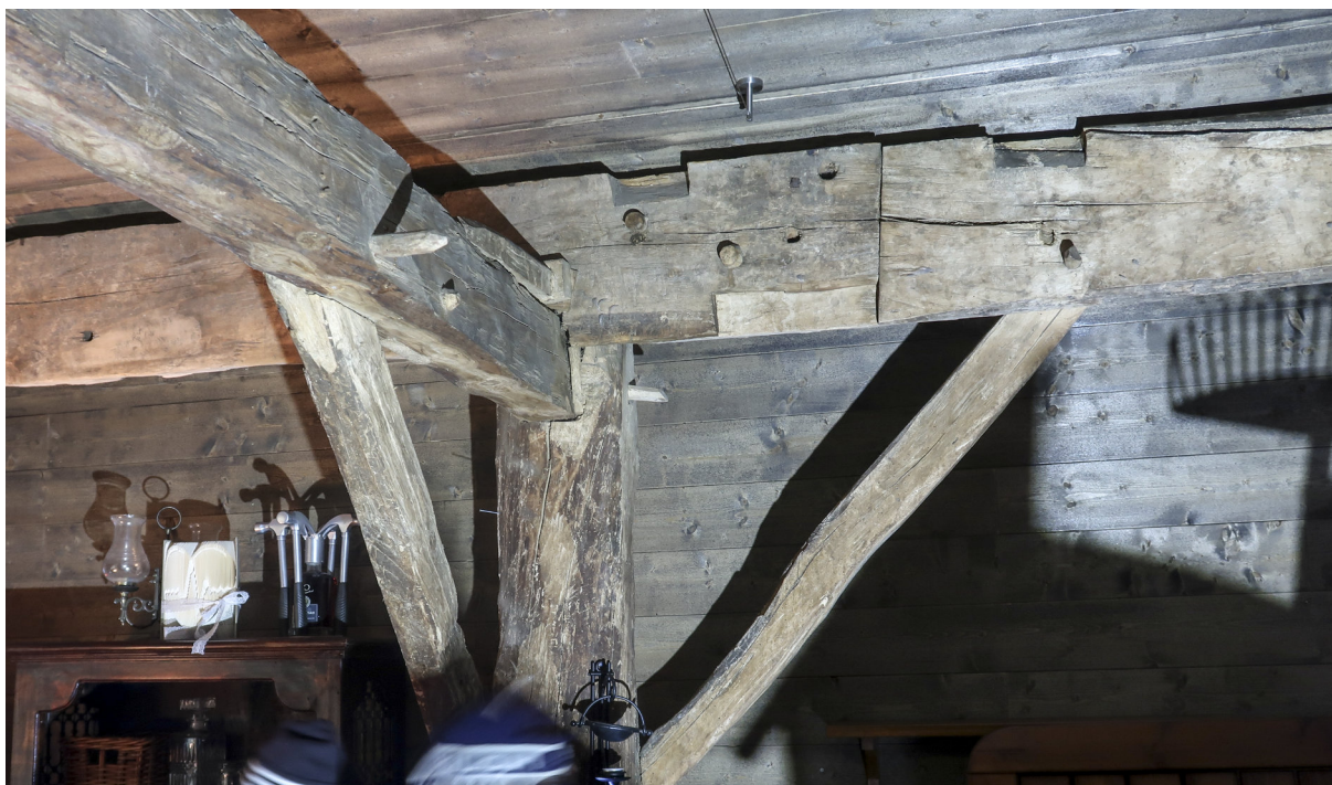
Fig. 14. Døme på informasjon frå «det store laboratoriet». Plassering og utforming av laskeskøyt. Skøyten har klart seg fint i nokre hundre år. Frå løa til Håvard H. Kleiveland på Vedo.
