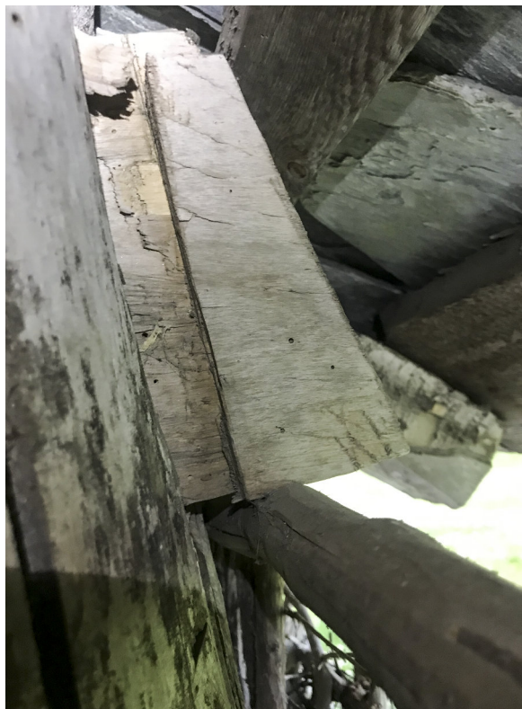
Fig. 11. Eit kort betahovud får utløa i Myrane på Haugo, det er ned mot ein tomme langt øvst. Nok eit døme på at dei gamle tømrrane ikkje kvitte seg med å vera praktiske. Emnet var antakeleg for kort, dei andre betahovuda i denne løa er meir normal lengde på. Betahovudet står for øvrig ikkje i kontakt med stavsøyro.
