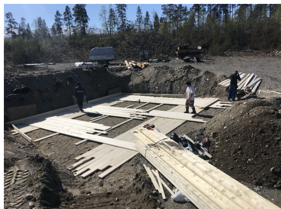
Fig. 28. Venstre: Målselv den 28.05.2019 klokka 01:15: Nattskift der tomte er ferdig planert og klar til komprimering. Høgre: Tre-fundamentet er starta på. Det gjekk med rett i overkant av 2,5 kilometer med konstruksjonsvirke.
