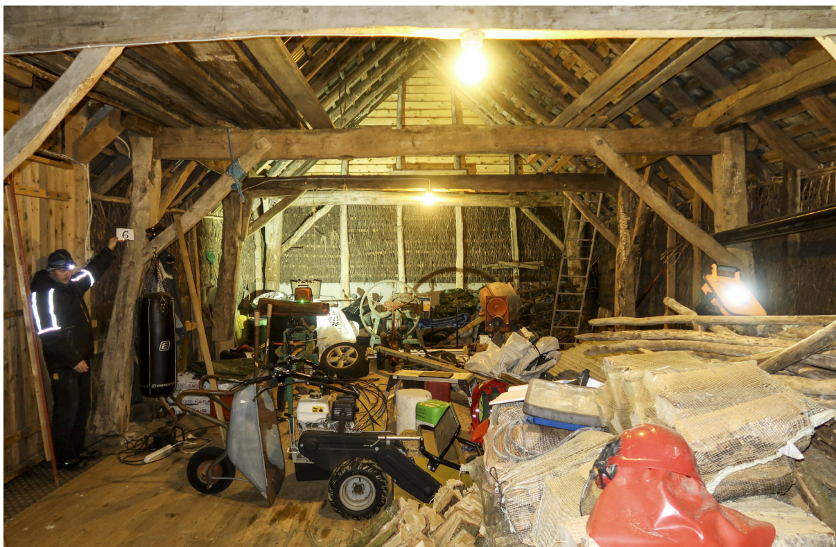
Fig. 3. Typisk interiør i grindabygg. Heimeløa på Rolf M. Kleiveland sitt bruk på Kleiveland.
