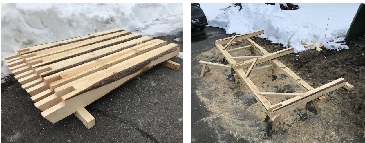
Fig. 25. Venstre: Stavane på 9x10 tommar er klare. Høgre: Eine langveggen er felt saman med stavleier, stavar og sneband. På Midt-Troms Museum sitt område i Sundlia i Målselv.
