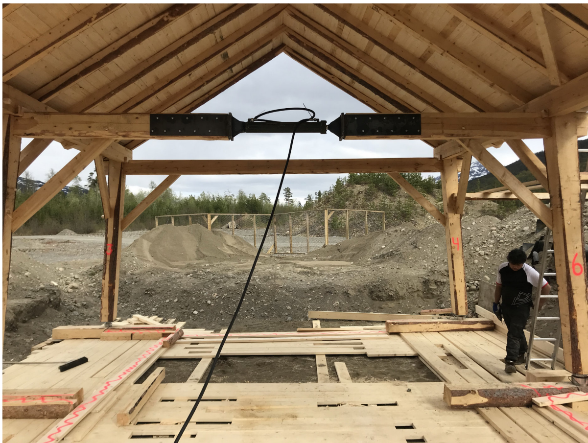
Fig. 45. Grinda med sutak klar. Det er kapp ut eit stykke av midste beten, der strekkmålaren er montert inn.
