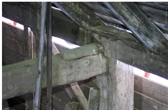
Fig. 8. Klamp (bråtalaske) på beten i Bullaløa på Valestrand. I denne løa ser det ikkje ut til å vera noko oppatt-brukt material.
